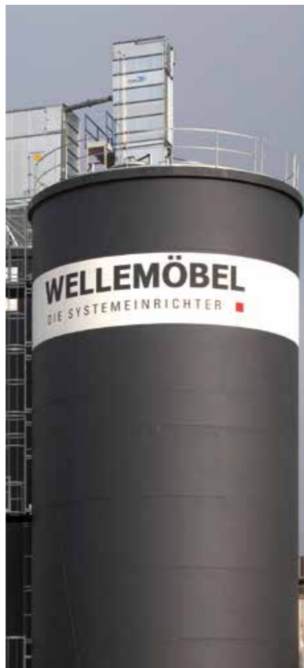
Holzspäne verbrennt die neue Wärmanlage, was 500.000 Euro pro Jahr an Heizkosten spart.
